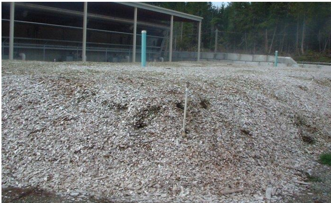
Figura 6: Biofiltro de naturaleza orgánica para eliminación de olores
