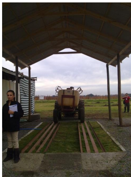
Figura 7. Sistema biobed para recolectar los vertidos de caldo durante la preparación de cubas de tratamiento o durante las aguas de lavado de la maquinaria agrícola.
