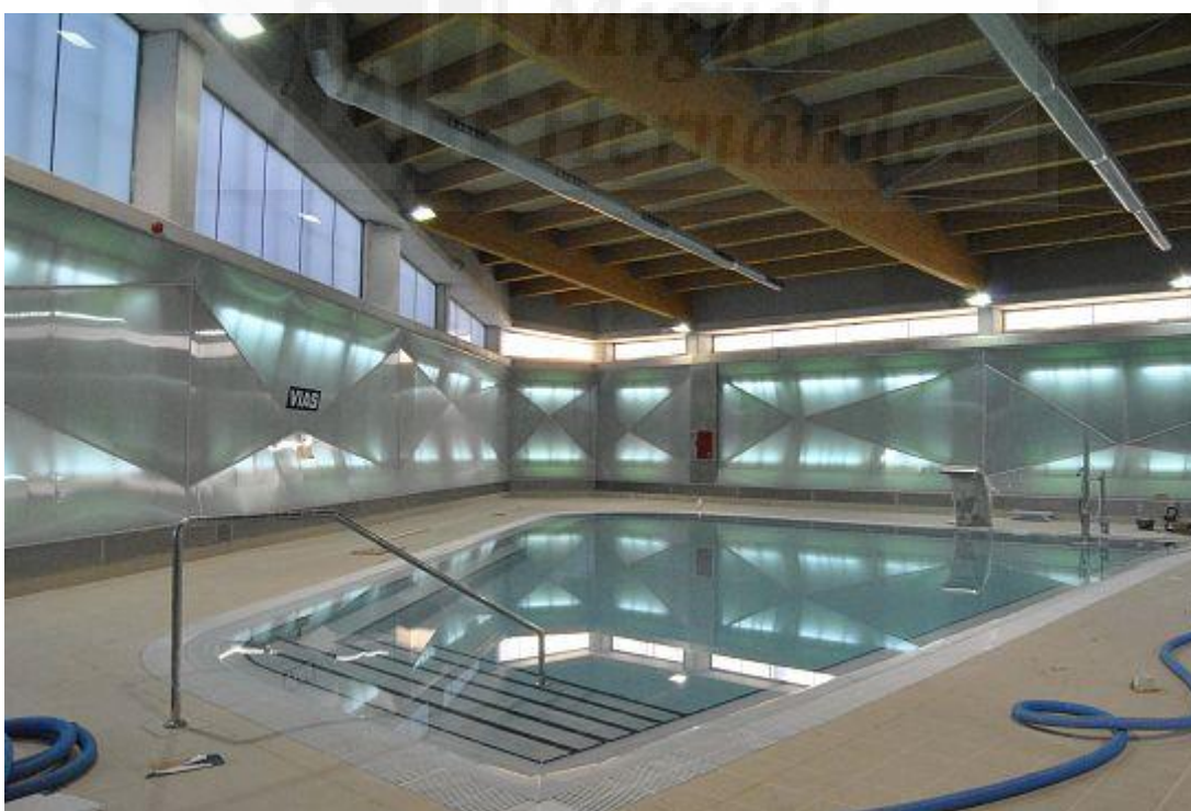
PISCINAS CARRÚS (VASO POCO PROFUNDO)
