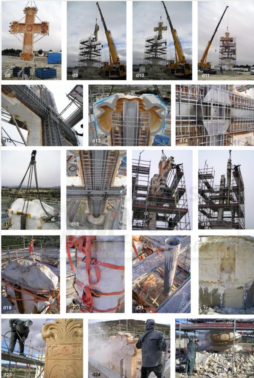
**Ilustración 218.** Elevación de primera mitad de la segunda parte (d8-d11). Estructura interna y viga de la segunda parte (d12-d18). Elevación de la segunda mitad de la segunda parte (d17 y d18). Fundido del hormigón (d19). Abrazaderas de refuerzo (d20). Respiraderos para brazos (d21). Desprendimiento de capa externa de los fragmentos (d22). Aplicación de chorro de agua a presión para desprendimiento de yeso (d23-d15).
