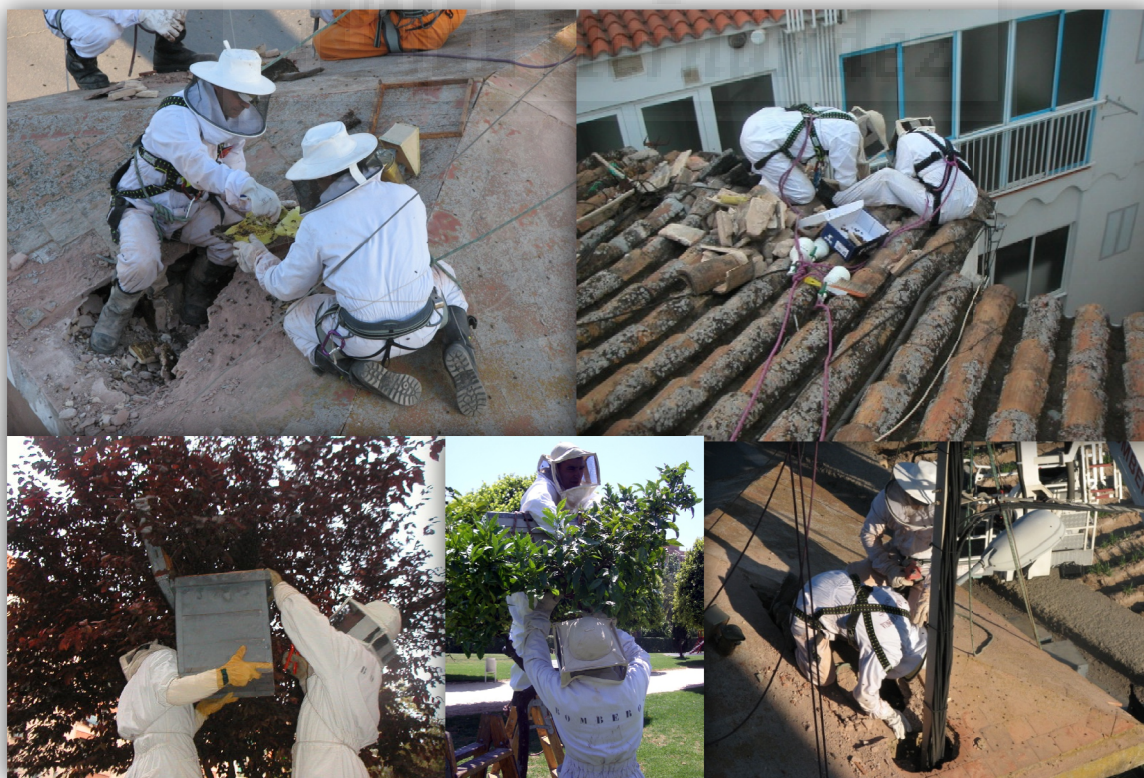
Figura 30. Recogida de una colmena en un edificio que implica romper el techo y recogida de un enjambre en un parque público.
