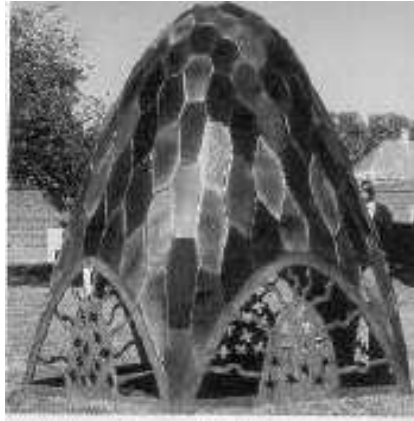
Figura 4.25.b: Cúpula geodésica transformada a paraboloides.
