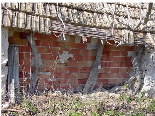
*Fig 1.5. Pilares de la barraca. Troncos de morera sin desbastar.*
