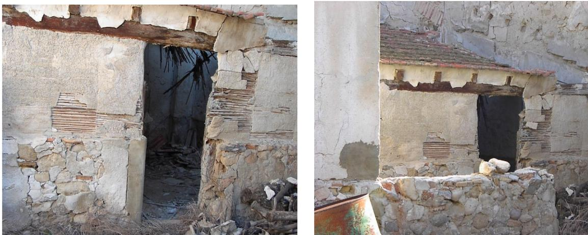
*Fig 1.10, 1.11. Detalle de cerramientos con caña. Alquería de la finca La Caseta.*
