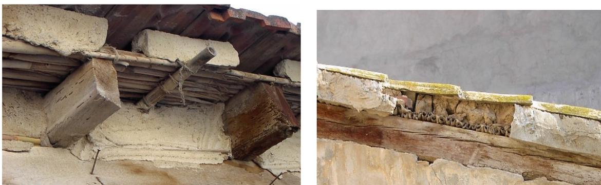
*Fig 1.12, 1.13. Detalle de caña común en forjados con teja alicantina y con teja árabe.*
