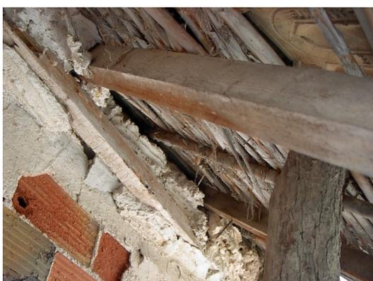
*Fig 1.6. Caña común bajo cubierta.*
