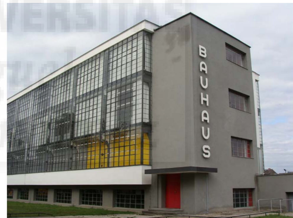
Fig. 1-66 Edificio de la Bauhaus en Dessau.
