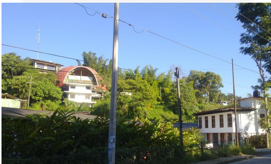
Foto: instalaciones de la tosepan: auditorio y oficinas.
