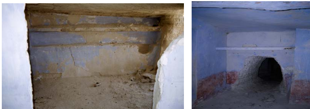
Anaqueles sobre un banco corrido y anaquel sobre la puerta de un túnel.
