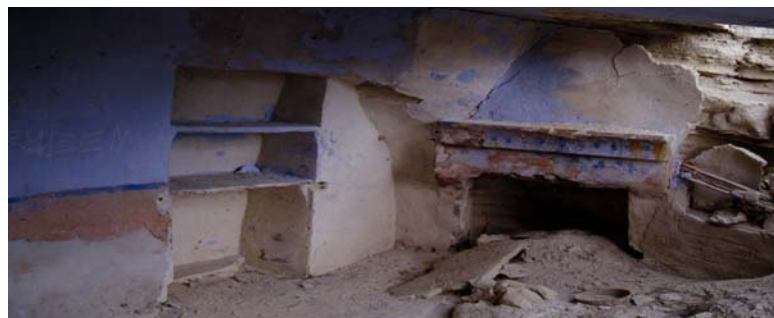
Línea de zócalo de color añil sobre un zócalo ocre en MH102
