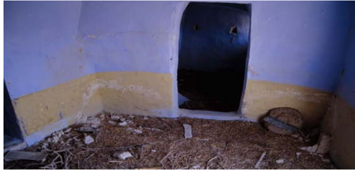
Zócalo pintado de un ambiente Principal en MH107 (Barrio Noroeste).
