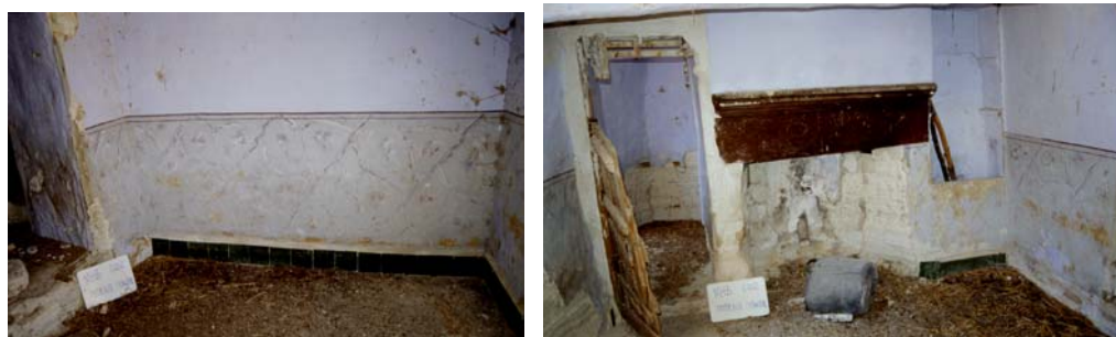
Zócalo pintado de imitación de mármol. Barrio de la Estación de las Minas M203.
