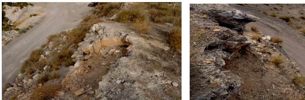
Restos de la bóveda del horno en el depósito.
