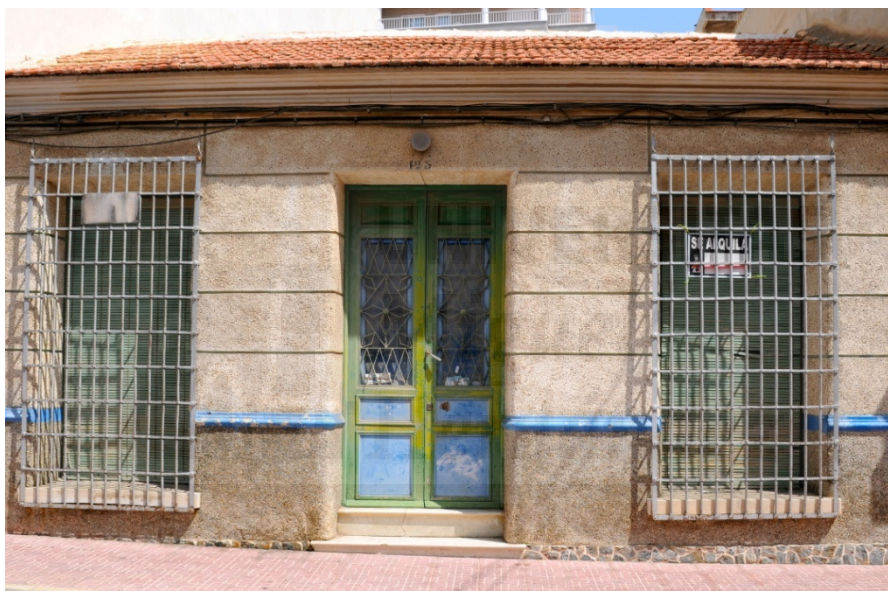
Fotografía 14.3 Casa de línea clásica. Típica de la construcción entre los años 40 y 50 del siglo XX Colección M.C.LL.
